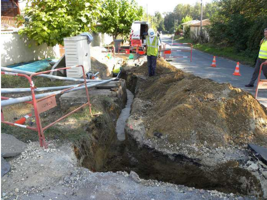
Vue de la tranchée d'adduction.
