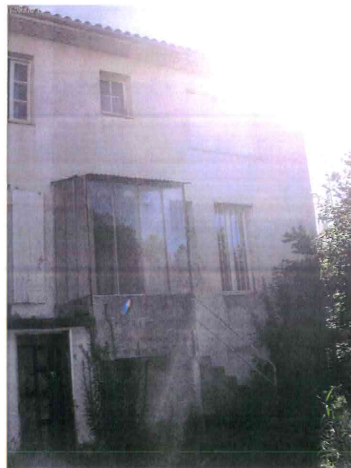
Vue Sud Ouest
