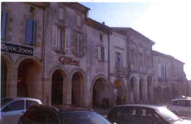
Façade nord-est de la place. Galerie d'arcades en rez-de-chaussée. Nombreux commerces.
