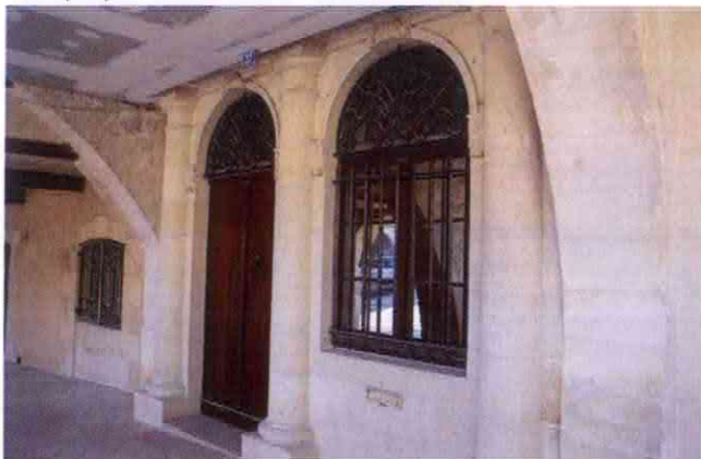
Détail d'un immeuble sous les arcades. Installation récente de faux-plafond.
