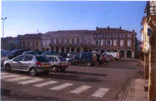
Façade sud-ouest de la place. Galerie d'arcades en rez-de-chaussée. Mairie à l'angle sud en travaux.
