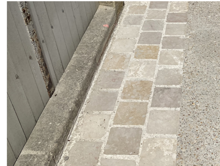
Bande perspirante en pavés calcaire - Bourg de Puissegui - AGENCE METAPHORE
