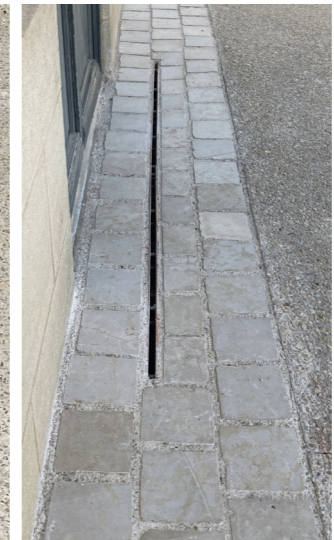
Bande perspirante en pavés calcaire - Bourg de Puissegui - AGENCE METAPHORE
