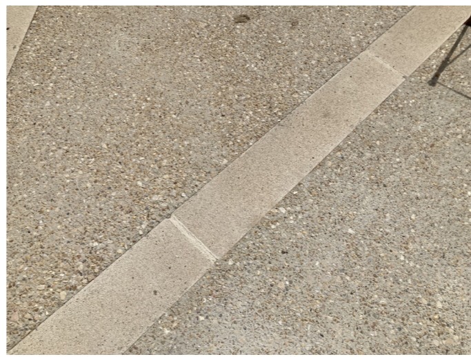
Bordure en béton bouchardé ton pierre largeur 0.20, profil pierre - bourg de Puissegui - AGENCE METAPHORE
