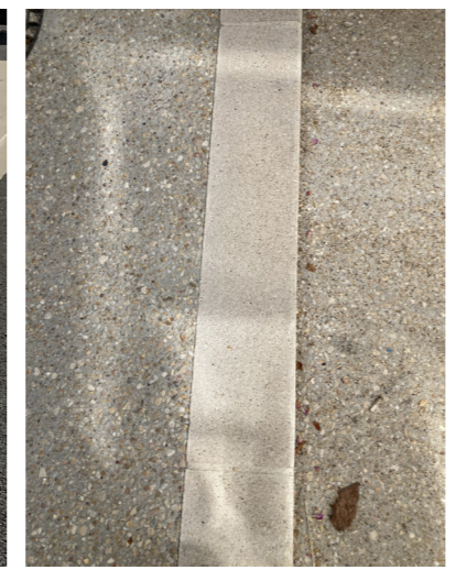
Bordure en béton bouchardé ton pierre largeur 0.20, profil pierre - bourg de Puissegui - AGENCE METAPHORE
