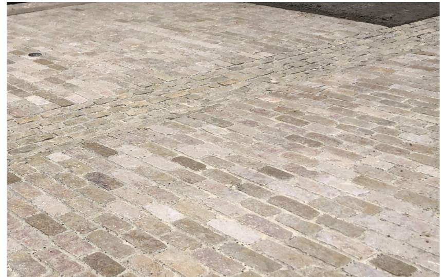
Dallage/pavage calcaire sur les surfaces surfaces de plateaux traversants, trottoirs au droit des seuils des batis remarquables (maisons nobles). Ref Calminia
