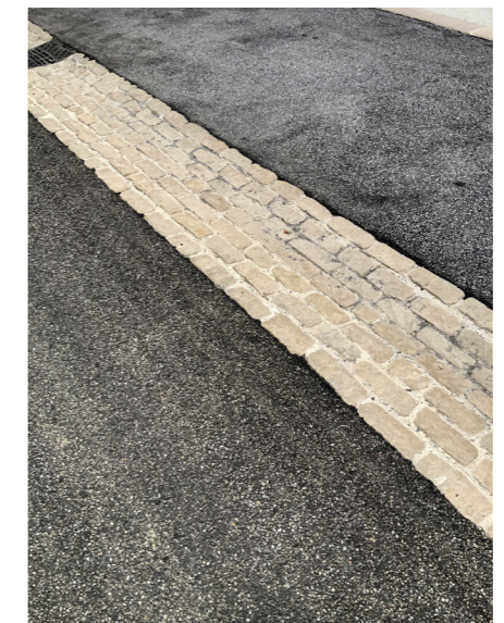
Enrobé grenailé et caniveau en pavés Rue Saubotte
