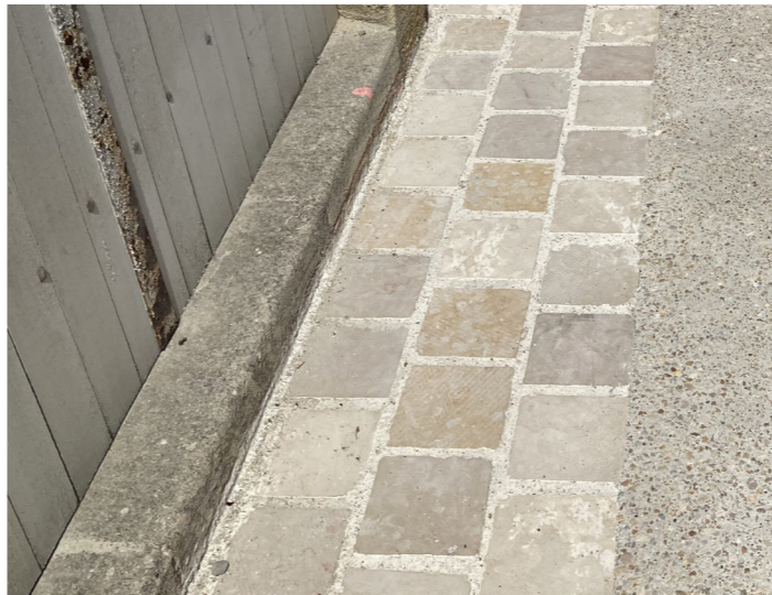
Bande perspirante en pavés calcaire - Bourg de Puisseguin - AGENCE METAPHORE
