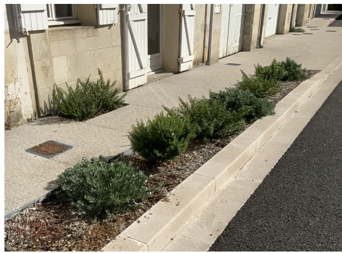
Bordure en béton bouchardé ton pierre largeur 0.20, profil pierre - bourg de Puisseguin - AGENCE METAPHORE
