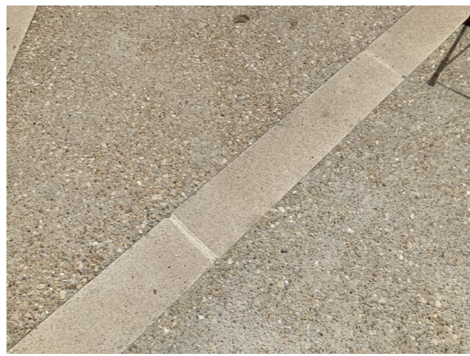
Bordure en béton bouchardé ton pierre largeur 0.20, profil pierre - bourg de Puisseguin - AGENCE METAPHORE
