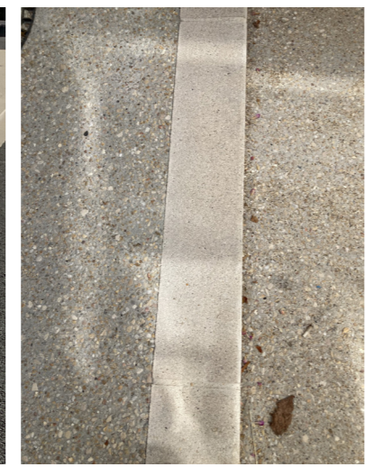
Bordure en béton bouchardé ton pierre largeur 0.20, profil pierre - bourg de Puisseguin - AGENCE METAPHORE
