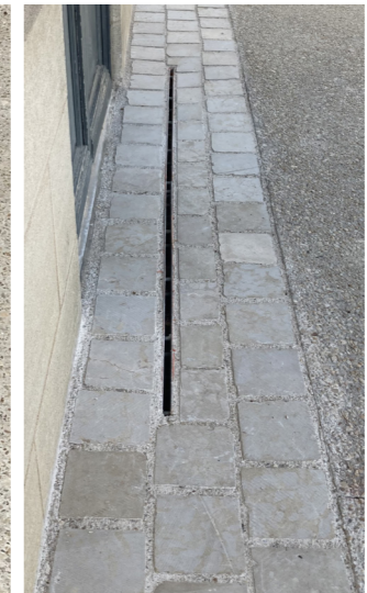
Bande perspirante en pavés calcaire - Bourg de Puisseguin - AGENCE METAPHORE
