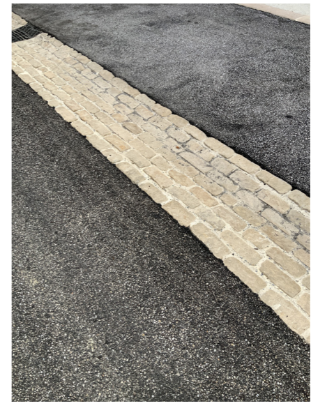
Enrobé grenailé et caniveau en pavés Rue Saubotte
