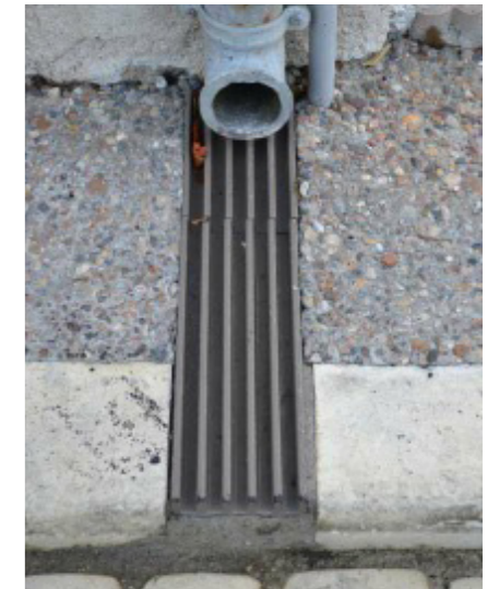
Collecte des descentes EP : caniveau extra plat
