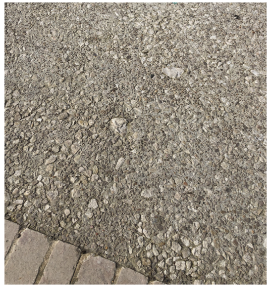
Béton désactivé "rustique"
